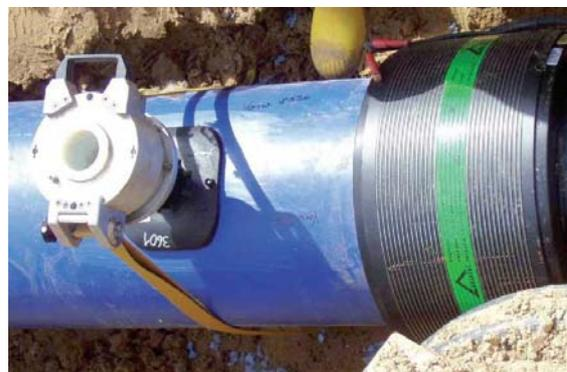
Рис. 4. Вентиляционный отвод на водопроводе диаметром 450 мм для питьевой воды (седлообразный отвод SA-TL с механическим прижимным устройством)
