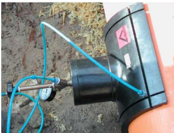
Рис. 7. Выполнение подключения к газопроводу диаметром 315 мм под рабочим давлением с помощью седлообразного отвода FRIALEN XL SA-XL
