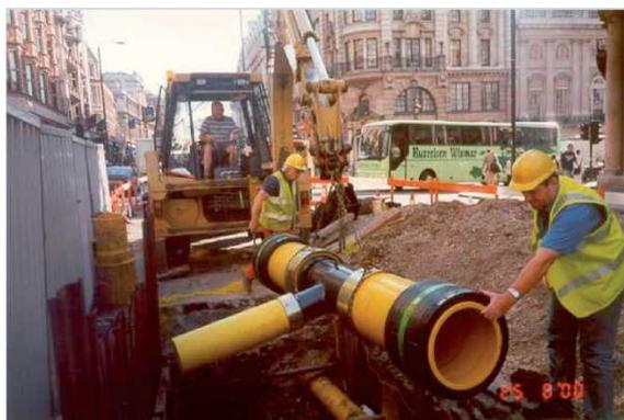
Рис. 3. Дорого! Подключение отвода к газопроводу диаметром 500 мм
