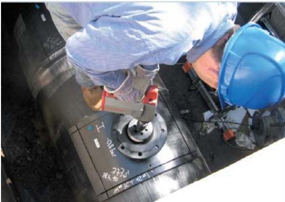
Рис. 12. Врезка в трубу диаметром 900 с установкой фланца DN150.
