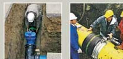
Каждому специалисту понятно: большая длина вставки трубы в фитинг ведет к лучшей компенсации деформаций трубы и равномерному распределению давления расплава. В результате мы получаем большую надежность процесса сварки и большую прочность соединения.
