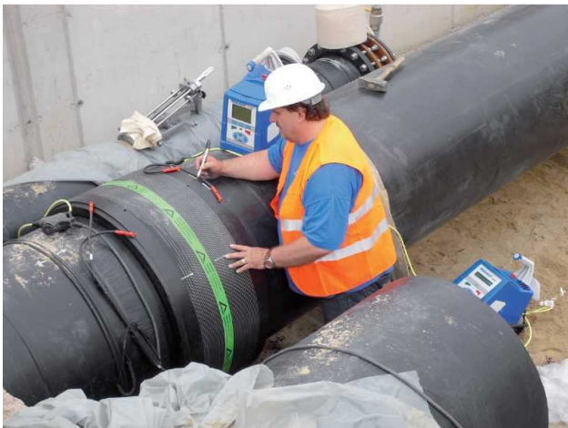
Рис. 2. Внешнее армирование сдерживает расширение муфты при выполнении сварного соединения.
