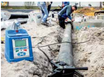
Качественный монтаж и простая сварка патрубков-накладок FRIAFIT ASA-TL.
