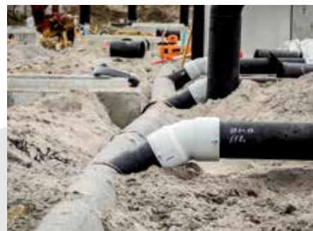
Гомогенное сварное соединение трубопровода из ПЭ-ВП
